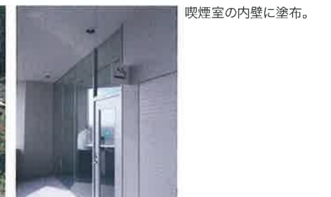
喫煙室の内壁に塗布。
