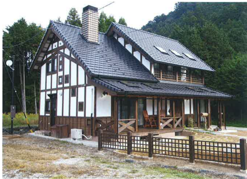
塗布箇所/内壁・天井：約415㎡、屋根（ルーフィング）：約160㎡、外壁：約175㎡。
