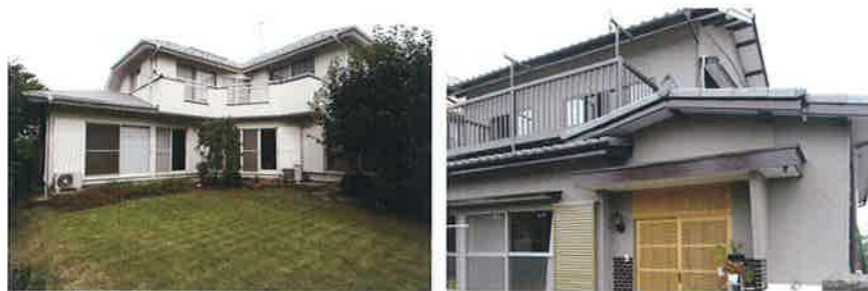
M邸：塗布箇所/屋根：130㎡、外壁：140㎡。 K邸：塗布箇所/内壁・天井：40㎡、外壁：260㎡。
