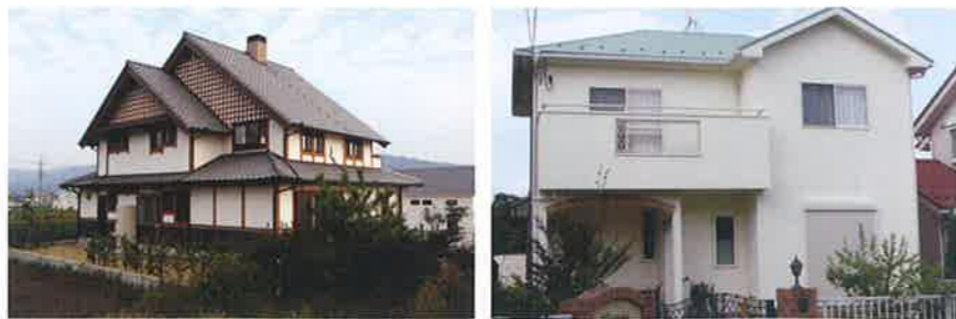
T邸：塗布箇所/屋根：300㎡、外壁：180㎡他。 S邸：塗布箇所/屋根：94㎡、外壁：140㎡。
