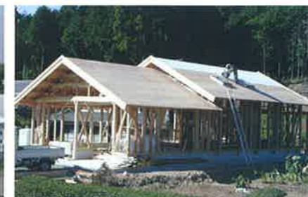
瓦屋根家屋の野地板に塗布。
