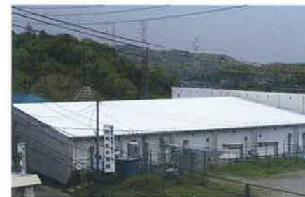
冷蔵倉庫屋根に塗布。
