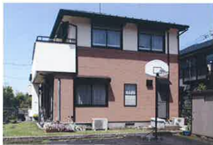
O邸：塗布箇所/屋根：90.9㎡、外壁：156.95㎡。
